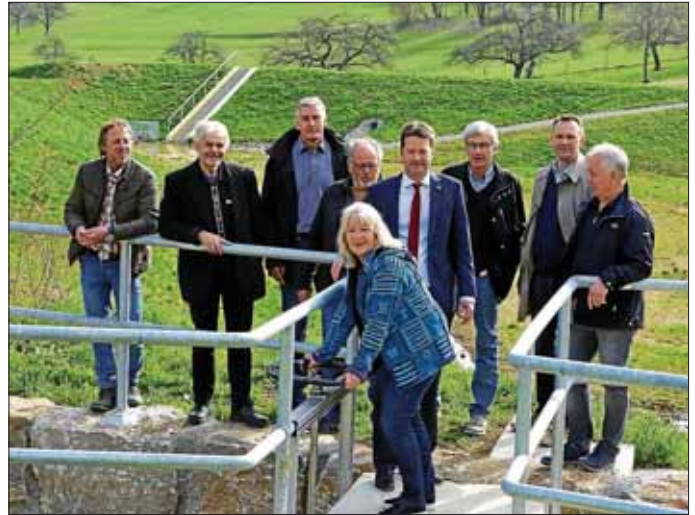
Kommt wirklich ein Hochwasser, dann wird nicht händisch am Rad gedreht, wie im Bild von Ortsvorsteherin Meta Staudt. Die Anlage funktioniert weitgehend automatisiert und ferngesteuert.
