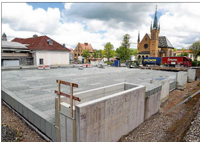
Baustoffe sind rar, was die Fertigstellung der Tiefgarage leider verzögert.
